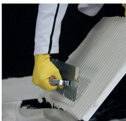
(Processo de dupla colagem) Com o lado liso da desempenadeira de aço, estender a argamassa por todo o tardo (verso) da rocha, apertando—a contra a base. Em seguida, passar o lado dentado da desempenadeira a um ângulo de 60" em relação à base, formando cordões e sulcos. Repetir o procedimento anterior no contra-piso onde a rocha será instalada.
